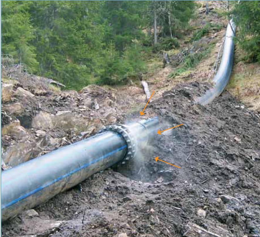
Besonders bei geodätischer Höhe sind im Tiefpunkt Innendrucke  $> 10/16$  bar vorhanden.
