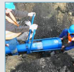
Verlegegerät für REINOGRIP Installation tool for REINOGRIP
