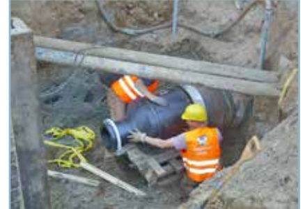
Reduzierung mit HP-Flansch Reducer with HP flange
