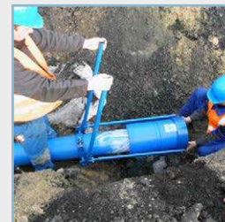
Verlegegerät für große Abmessungen von REINOGRIP Installation tool for large dimensions of REINOGRIP
