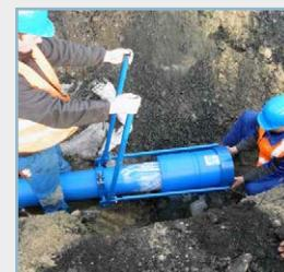
Verlegegerät für große Abmessungen von REINOGRIP
