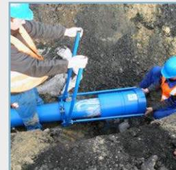
Verlegegerät für große Abmessungen von REINOGRIP
